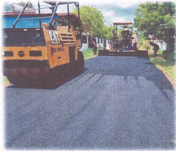
รูปภาพ ; โครงการซ่อมแซมถนน คสล. โดยวิธีเททับด้วยยางแอสฟัลท์ติกคอนกรีต ถนนสายจากหมู่บ้านไปวัดป่าเวฬุวัน ม.9 บ.หินโงม
