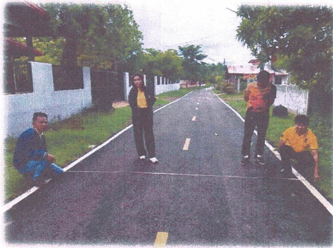
รูปภาพ ; โครงการซ่อมแซมถนน คสล. โดยวิธีเทท์บด้วยยางแอสฟัลท์ติกคอนกรีต ถนนสายจากหมู่บ้านไปรัดป่าเวหุวัน ม.9 บ.หินโงม
