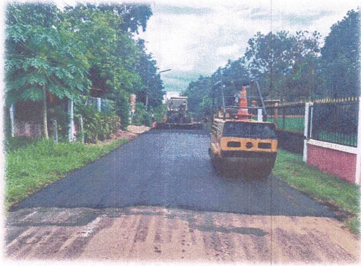
รูปภาพ ; โครงการซ่อมแซมถนน คสล. โดยวิธีเทท์บด้วยยางแอสฟัลท์ติกคอนกรีต ถนนสายจากหมู่บ้านไปรัดป่าเวหุวัน ม.9 บ.หินโงม
