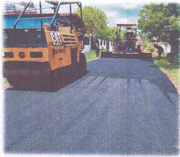
รูปภาพ ; โครงการซ่อมแซมถนน คสล. โดยวิธีเททับด้วยยางแอสฟัลต์ติกคอนกรีต ถนนสายจากหมู่บ้านไปวัดป่าเวสุวัน ม.9 บ.หินโงม
