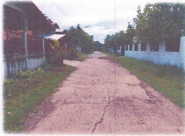
รูปภาพ ; ก่อนดำเนินการก่อสร้าง
