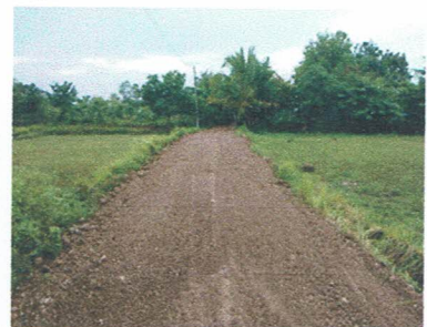
ดำเนินการแล้วเสร็จ
