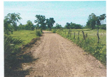
ดำเนินการแล้วเสร็จ
