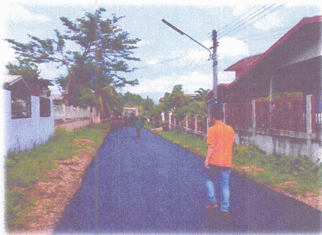
รูปภาพ ; ขณะดำเนินการก่อสร้าง
