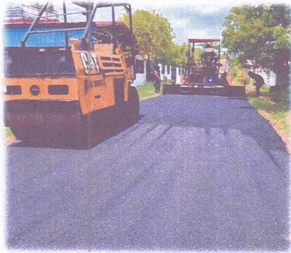
รูปภาพ ; โครงการซ่อมแซมถนน คสล. โดยวิธีเททับด้วยยางแอสฟัลต์ติกคอนกรีต ถนนสายจากหมู่บ้านไปวัดป่าเวหวัน ม.9 บ.หินโงม
