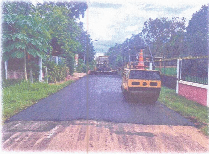
รูปภาพ ; โครงการซ่อมแซมถนน คสล. โดยวิธีเททับด้วยยางแอสฟัลต์ติกคอนกรีต ถนนสายจากหมู่บ้านไปวัดป่าเวสุวัน ม.9 บ.หินโงม
